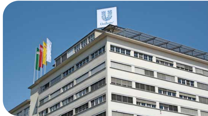
Unilever plant in Thayngen ein Zentrum für die Ernährung der Zukunft auf dem Knorri-Areal.
